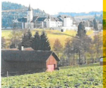
Normalbetrieb trotz Baustelle: Pflegeheim Sennhof.
